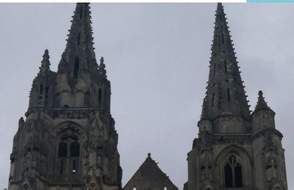
Photographie des deux tours. On peut remarquer que la tour nord est plus grande que la tour sud.
